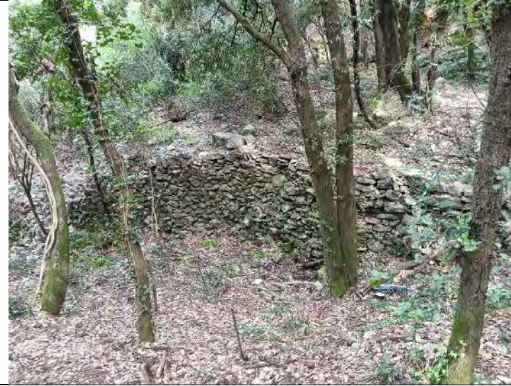
Vecchio Muro a secco di sponda lungo canale Fiascherino
