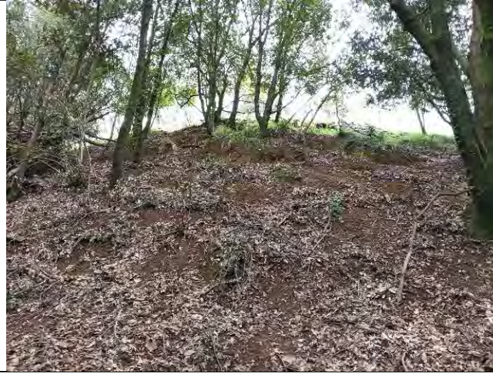
Tension Crack sotto Monte Rocchetta
