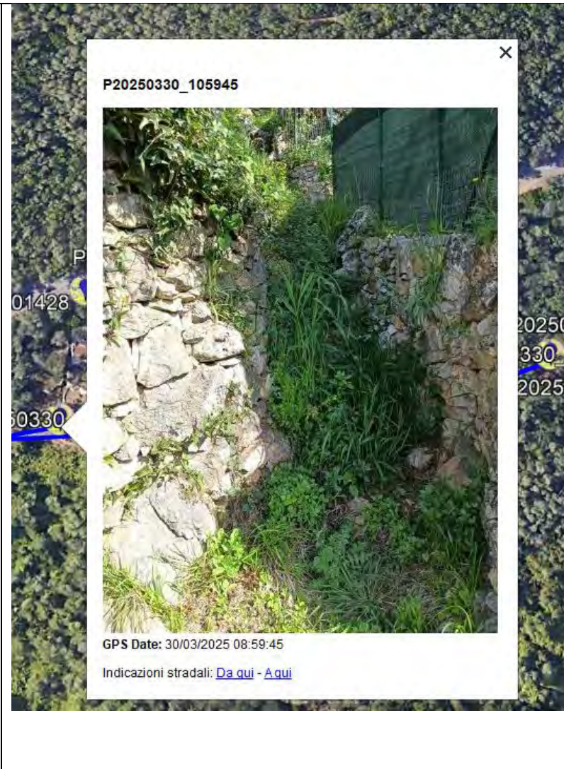
Prosecuzione verso valle sul sentiero CAI 433 sotto strada Provinciale
