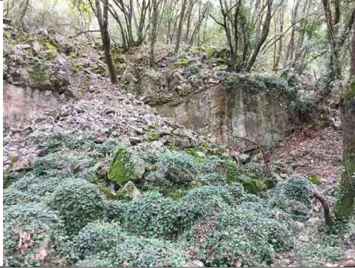
Accumulo di detrito sopra sentiero di collegamento CAI 411-422; si osservi che una parte di detrito (parte bassa) è coperto da vegetazione primaria mentre la parte alta è ancora scoperta; probabilmente corrispondono a due fasi di colata
