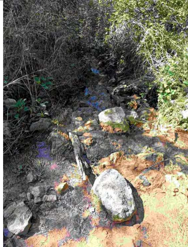
Massi trasportati dalla corrente nodo intersezione canale Capo d'Acqua e CAI 433
